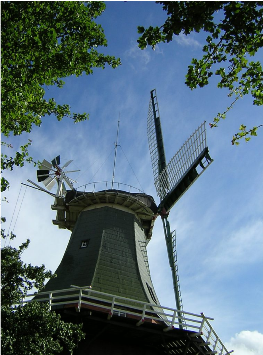
Die Windrose sitzt den großen Mühlenflügeln rechtwinklig genau gegenüber und bewegt die Flügel korrekt in den Wind
