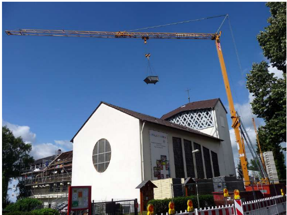
Der Baukran im Juli 2015 über der evangelischen Pauluskirche Gießen
