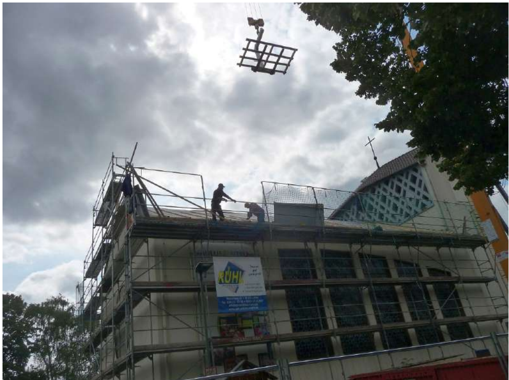
Ein sicheres Baugerüst ist die Voraussetzung für solide Bauarbeiten
