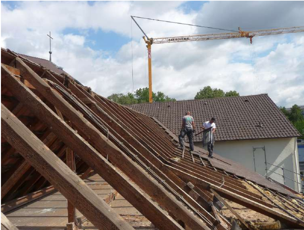
Das Dach des Gemeindezentrums wird im Zuge der Sanierung abgedeckt
