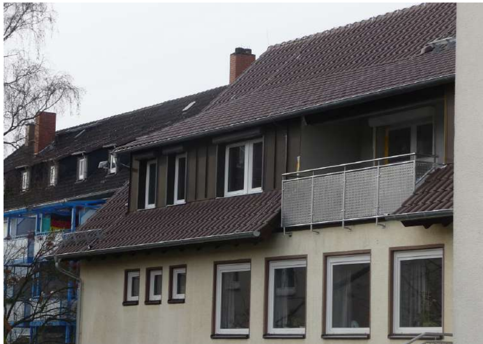
In die Pfarrwohnung wurde ein Balkon für die Pfarrfamilie eingebaut
