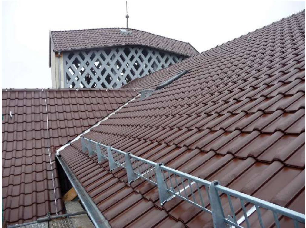
Die fertig gestellten Dächer der Kirche und des Gemeindezentrums
