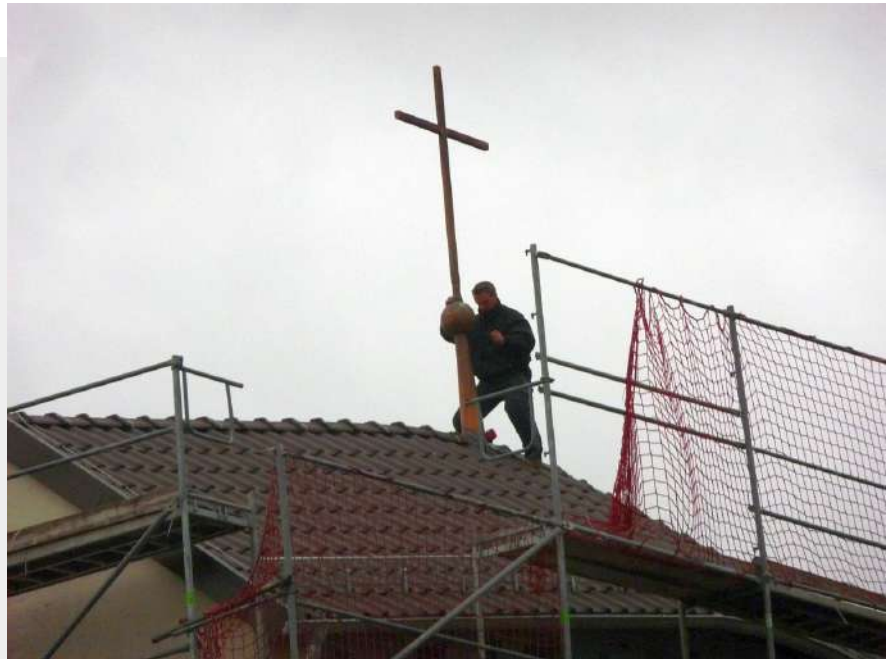
Als letzte Baumaßnahme wurde auf dem Kirchturmdach am vorigen Montag noch eine Stelle am Kupferkreuz ausgebessert
