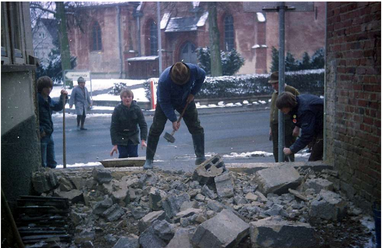
Ehrenamtliche Abrissarbeiten zur Vorbereitung der Erweiterung des Reichelsheimer Gemeindesaals im Jahr 1981
