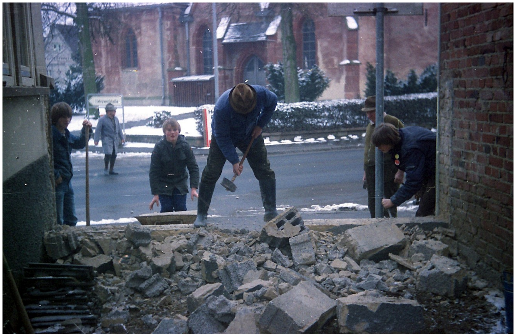
Anfang 1981 begannen bereits die ehrenamtlichen Abrissarbeiten zur Vorbereitung der Erweiterung des Reichelsheimer Gemeindesaals, im Zuge deren auch ein Kellerraum zum Jugendraum umgestaltet werden sollte.
