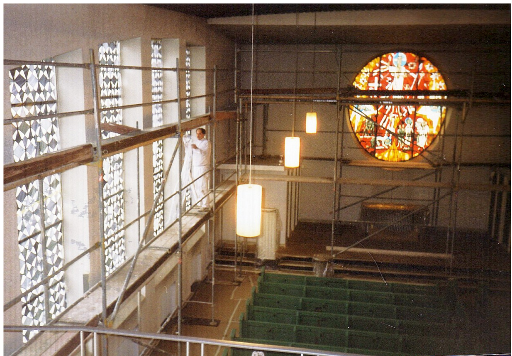
Ein Mitarbeiter beim Innenanstrich der Pauluskirche Gießen
