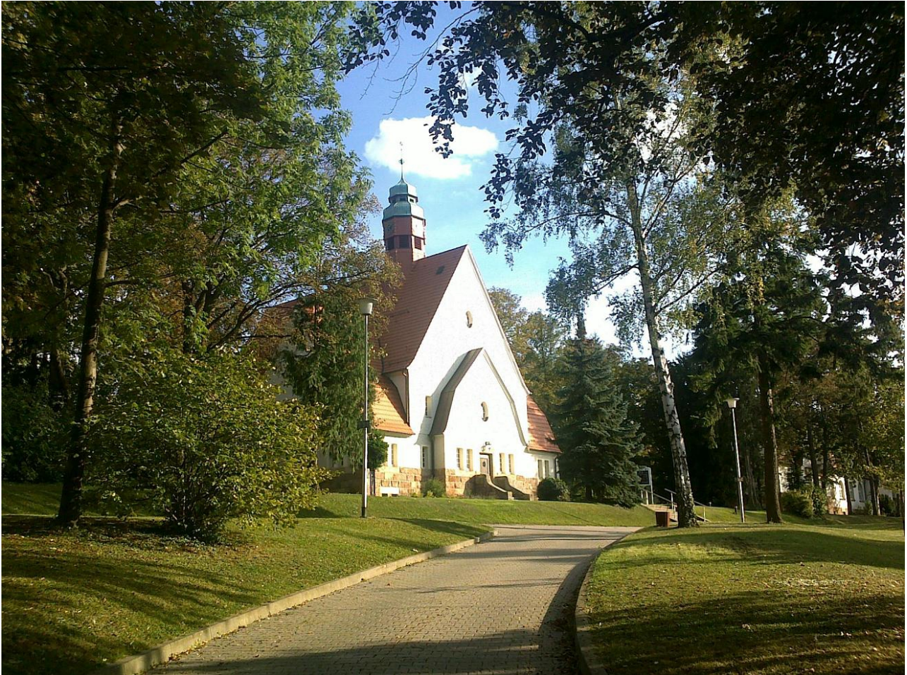
Kapelle der Rheinhessen-Fachklinik Alzey nach der Renovierung im Jahr 2011
